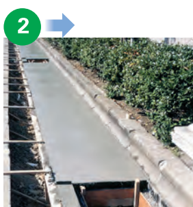
コンクリート打設
