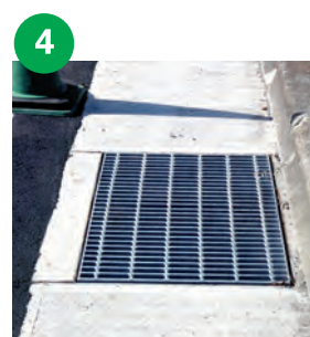
グレーチング設置
