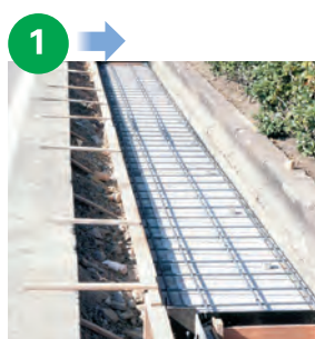
KCフォームの上に配筋した状態
