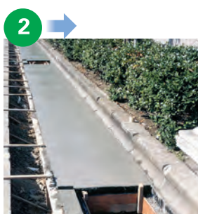
コンクリート打設
