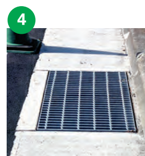
グレーチング設置
