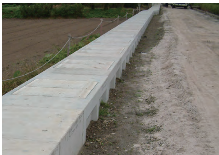
■片土圧による土留工法
