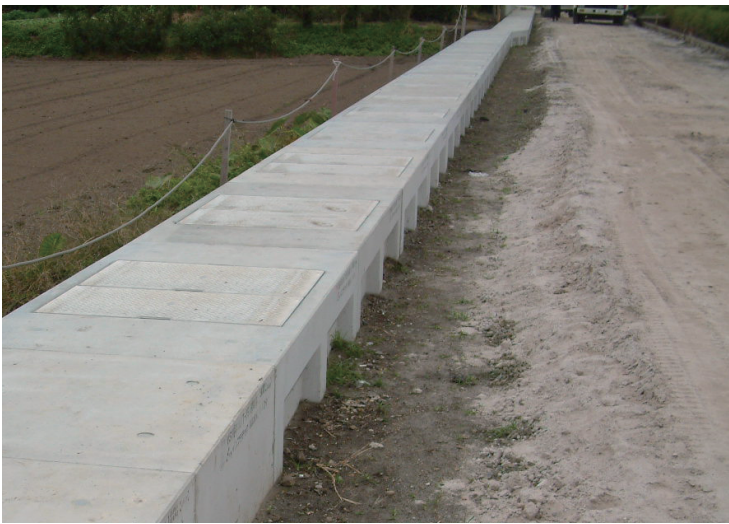
■片土圧による土留工法
