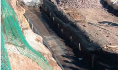
1.かごテンサー基礎敷設
