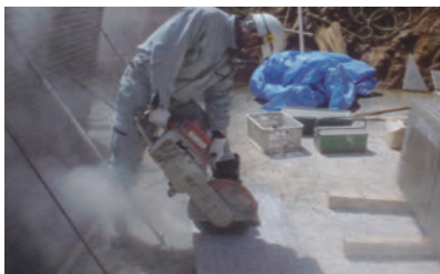
4.型枠パネル切断加工状況
