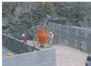
5.コンクリート打設状況
