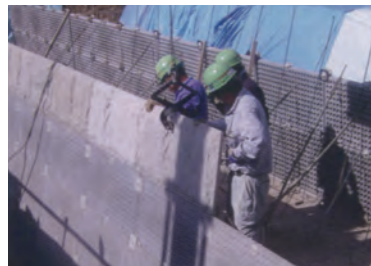
5.コンクリート打設状況
