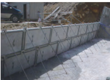
4.2段目設置完了状況
