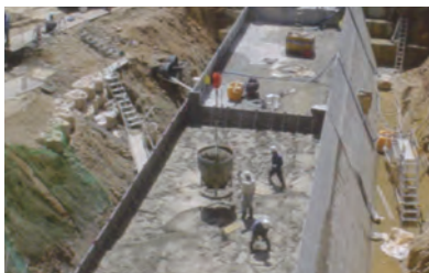
5.コンクリート打設状況
