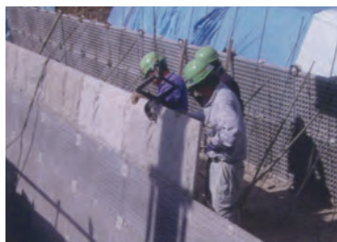
5.コンクリート打設状況
