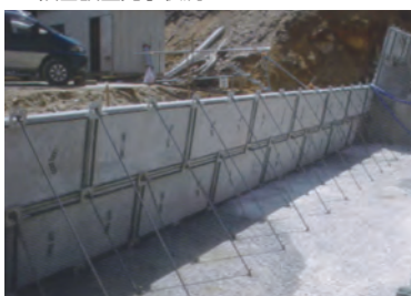
4.2段目設置完了状況
