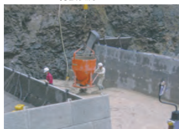
5.コンクリート打設状況
