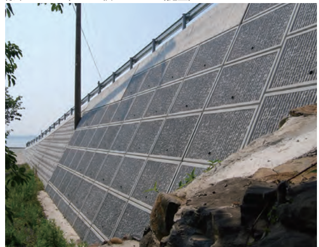
標準ブロック (かさね積みもたれ式擁壁)
