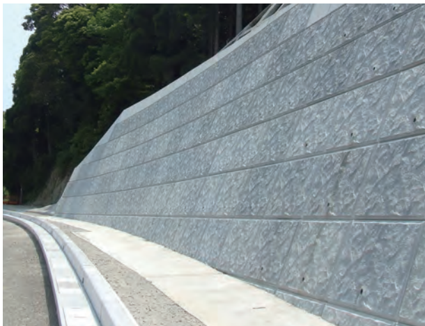
擬岩タイプ (階段積みもたれ式擁壁)
