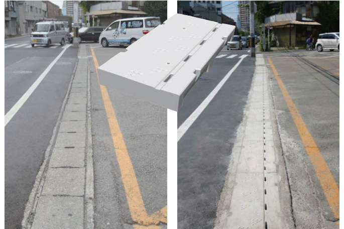
▲施工前 ▲施工後
