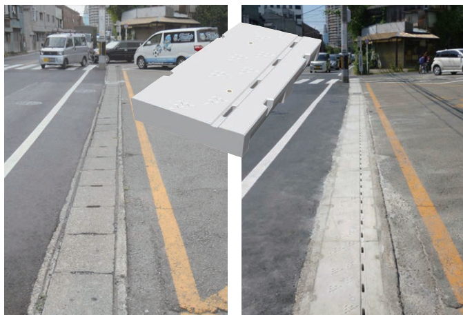
▲施工前 ▲施工後
