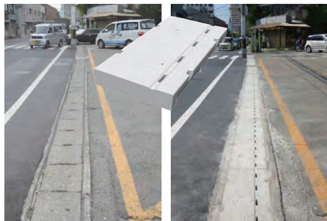
▲施工前 ▲施工後
