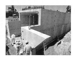
L型のブロックを横倒しした形で積み上げ、頂版スラブを載せてボックスカルバートと PC 鋼棒で緊張し一体化す る。部材がL型形状で自立するため施工性に優れ,特殊な技術を必要としないので施工性が良く,大幅な工期短縮と 高品質な施工が可能。張出し長さ8mまで対応する。「道路土工-カルバート工指針」に準拠。
