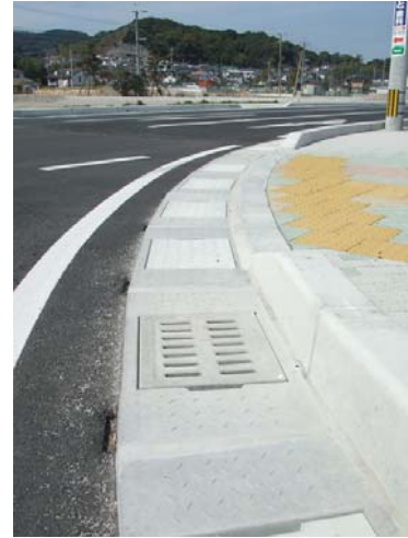
00002谷山リボーン側溝03. JPG
