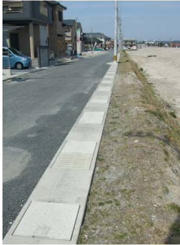
00001谷山リボーン側溝06. JPG
