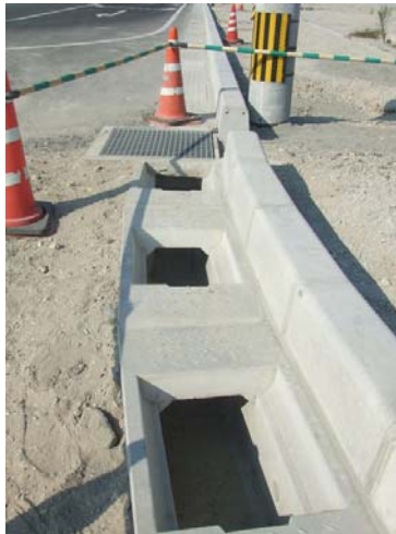
00003リボーン側溝谷山02. JPG
