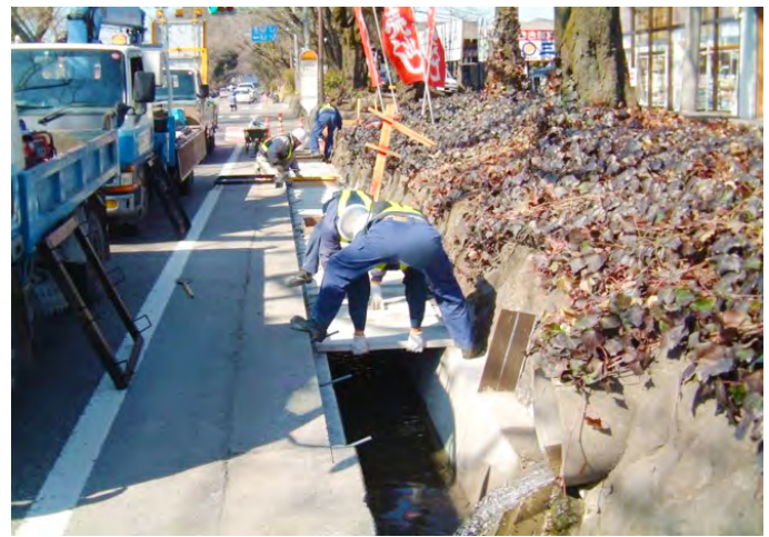
▼施工中(JSフォーム設置)
