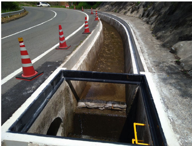
敷設前（蓋掛切断加工後）
