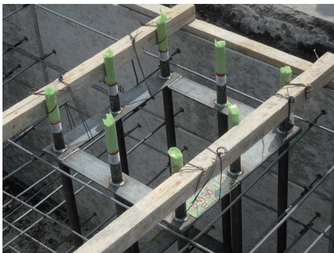
④アンカー筋設置
