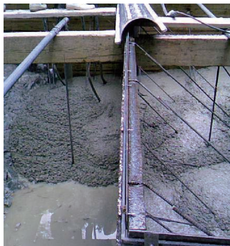
生コンは交互に打設。 生コン圧を打ち消しあい、 補強を最低限に抑えます。
