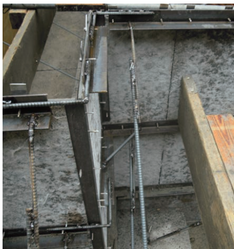
KC S F型組状況 支保材はアンクル（既製品）を使用。 背面のサポート筋と溶接して固定。
