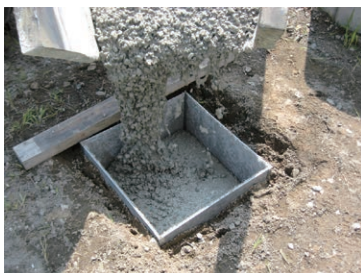
⑤生コン打設
