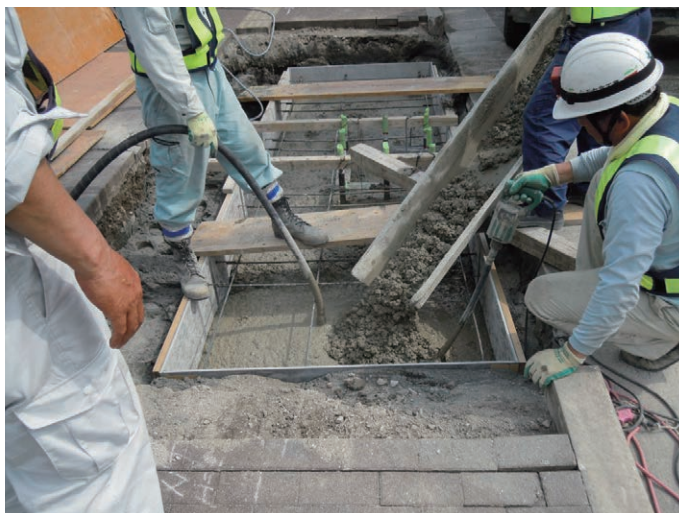
⑤生コン打設
