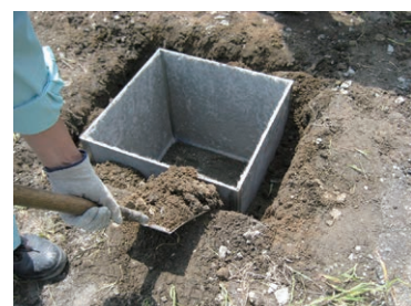
③周辺埋戻し(7,8割)・型枠レベル調整
