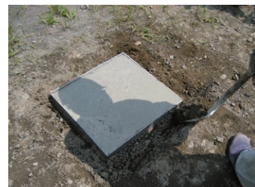
⑥所定高さまで埋戻し・養生
