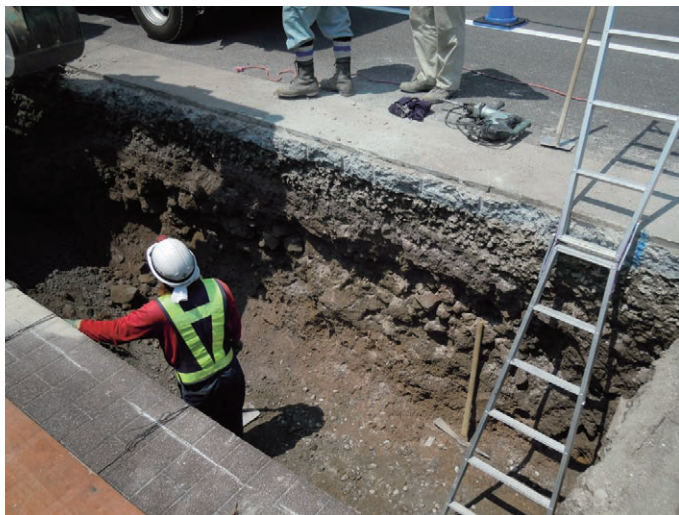
①掘削状況
