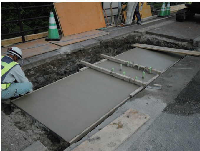
⑥所定高さまで埋戻し・養生
