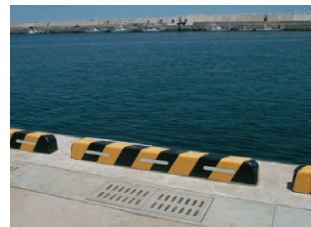
▲港湾での施工例
