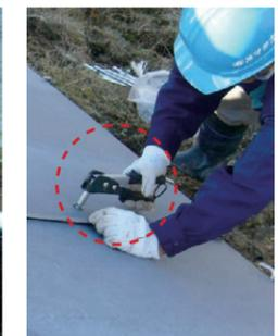
重ね合せ部に支承ゴムを貼り、左右の製品を10cm重ねて設置し(写真2参照)、下部はL字アンカー筋で、左右はボードファスナーで、天端は埋設プレートでそれぞれ固定します。
