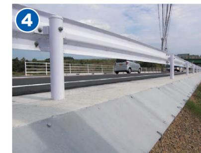
埋設プレートはボルトナットで製品本体に取付け、差筋で固定します。製品とコンクリートの間に隙間ができないように、棒パイプ等で入念に充填しながら路肩部に天端コンクリートを打設します。
