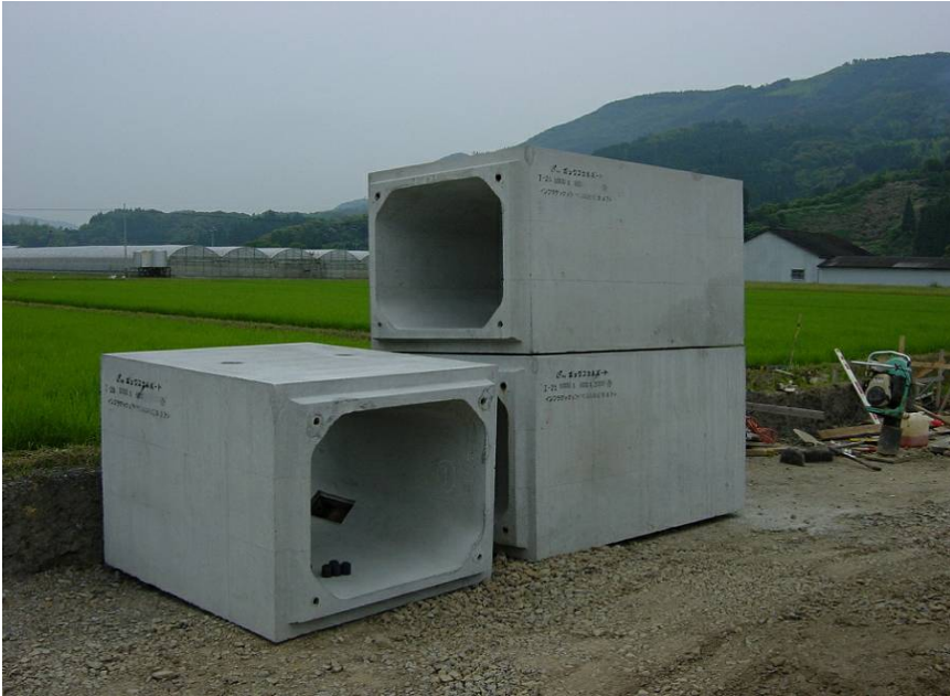
ボックスカルバート施工30
