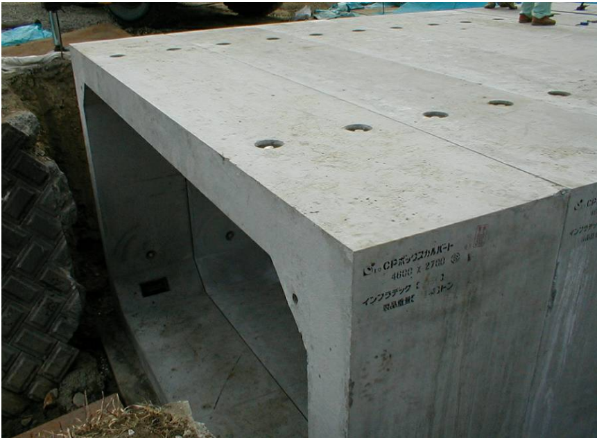
ボックスカルバート施工88
