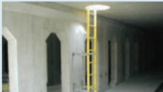
(梯子取付/スクリーン取付/水中ポンプ設置)
