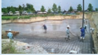
(鉄筋工/コンクリート工)
