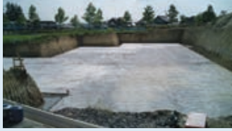
(土工/土留工/砕石工/均しコンクリート工)
