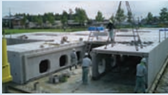
(プレキャスト部材据付工/組立工)
