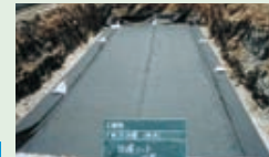
保護シート敷設
