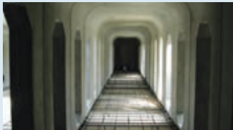
(鉄筋工/コンクリート工)
