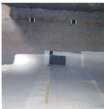
5 緩衝シートを貼付け
