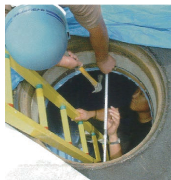
8 仕上げ作業 (固定金具で投入孔のシートを固定)
