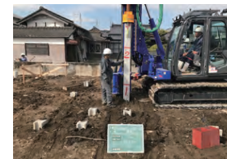
▼戸建住宅施工例
