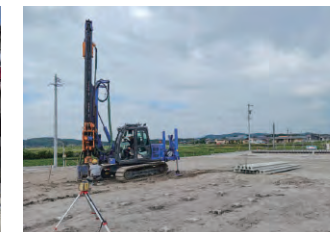
▼集合住宅施工例
