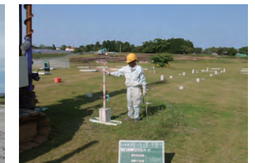
▼ソーラー発電パネル基礎施工例
