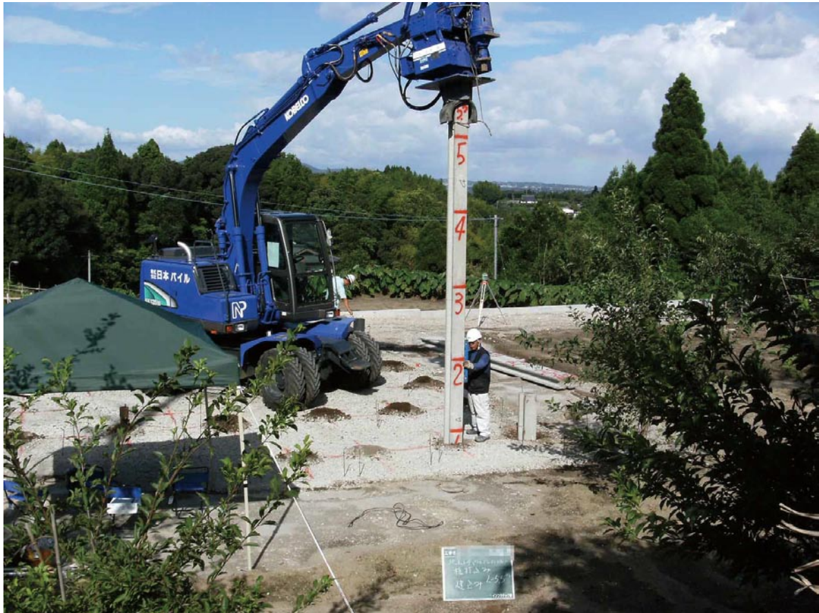
▲パイル打込み
