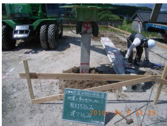
▲パイル打込み
