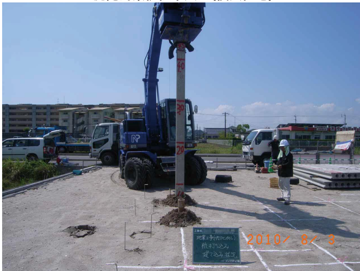
▲パイル打込み
