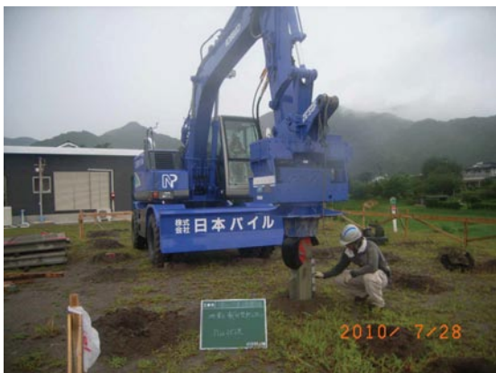
▲パイル打込み
