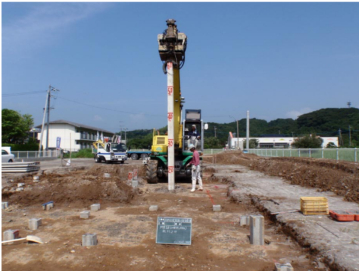
▲パイル打込み
