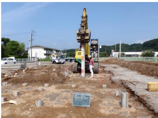
▲パイル打込み
