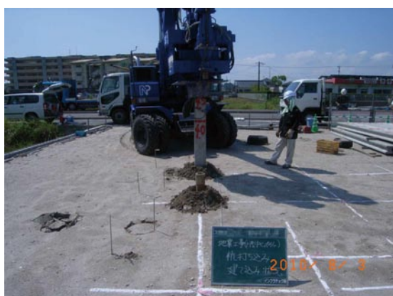
▲パイル打込み
