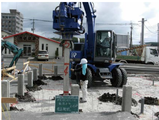
▲パイル打込み
