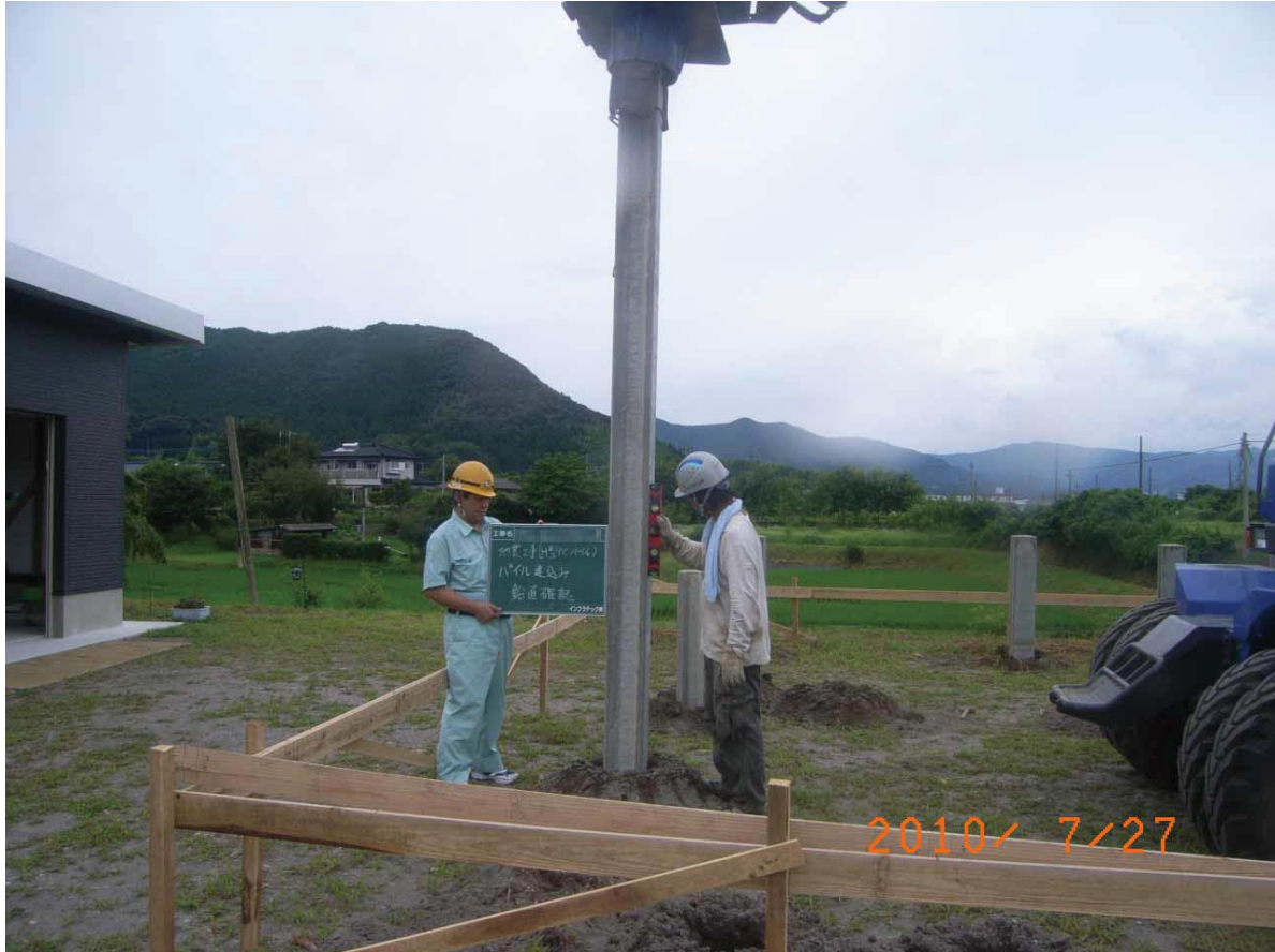
▲パイル打込み
