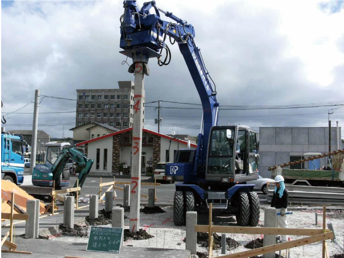
▲パイル打込み
