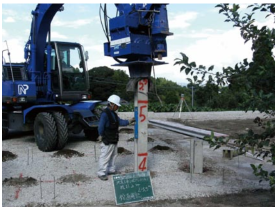
▲パイル打込み
