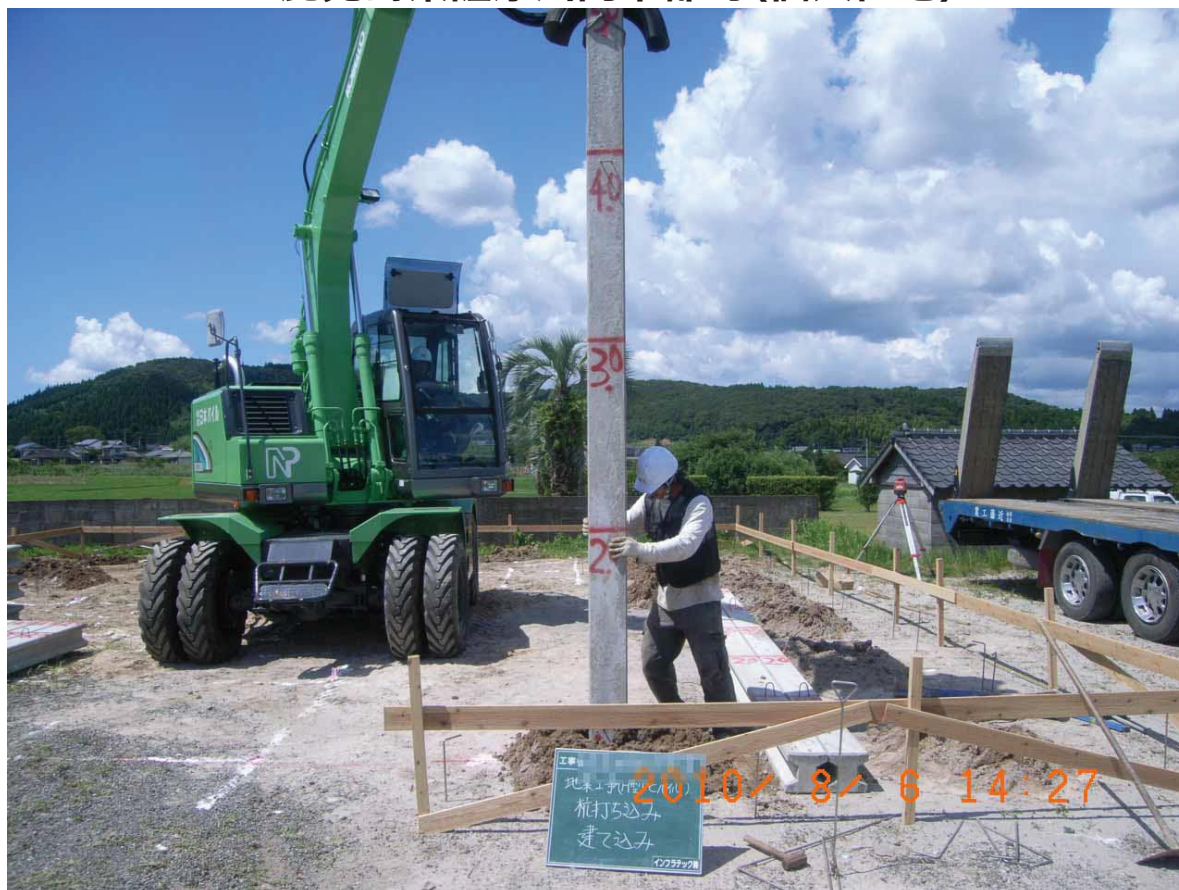
▲パイル打込み
