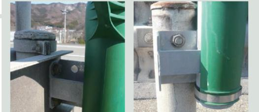
▲アタッチメントにより様々な取付方法に対応します。(写真は外径φ139.8mmの支柱に設置した例)
