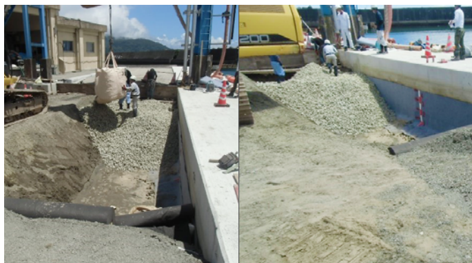
フレコンバック投入、巻出しと敷均し
