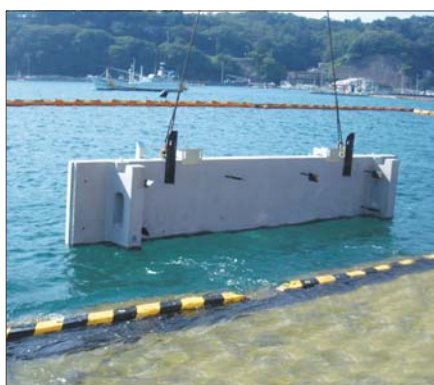
2. 残置型枠吊り状況
