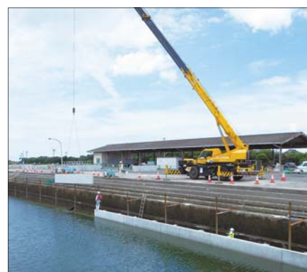
3. 残置型枠の水中布設
