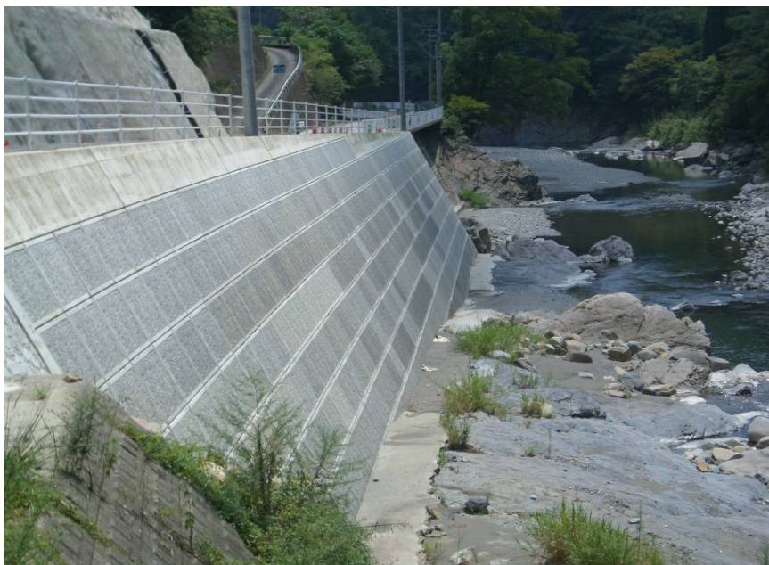
宮崎県国道265号竹原工区001
