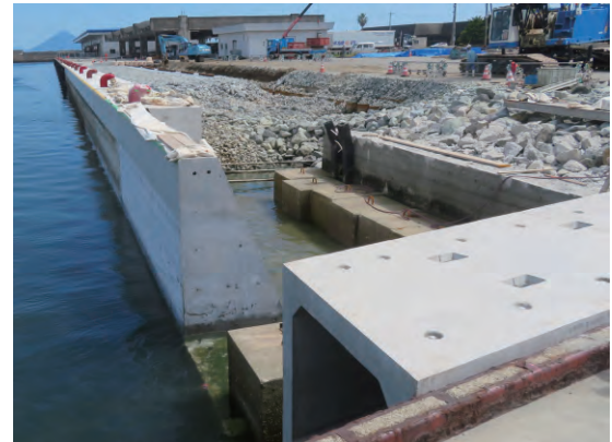
鹿児島県枕崎市:枕崎漁港 ボックスカルバート↑
