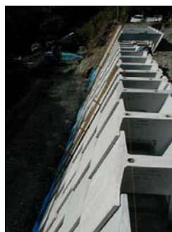
00015施工写真002. jpg
