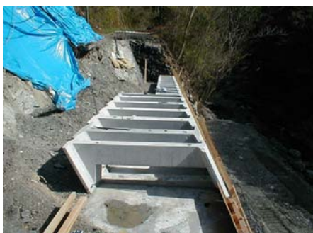
00014施工写真001. jpg
