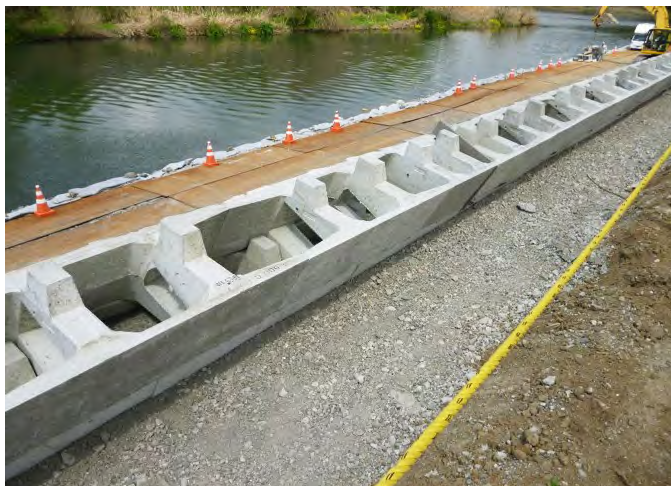
▼施工中(天端部)
