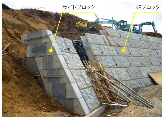
▼施工中(小口部)…小口止めにはサイドブロックを使用
