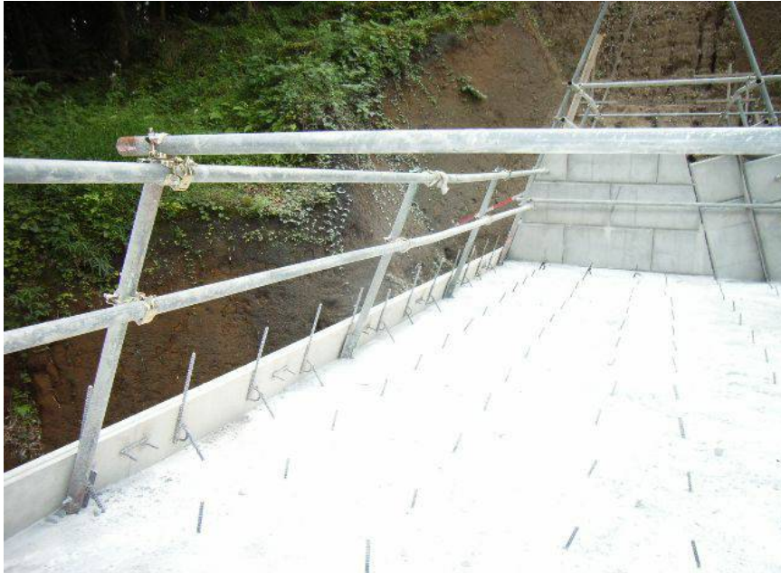
中間手摺取付
