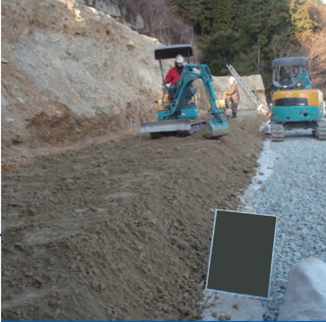
改良土の敷均し
