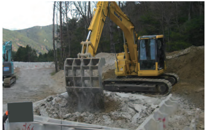
盛土材セメント改良(発生土仮置き場)
