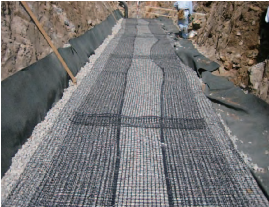
基礎かごテンサー（完成状況）
