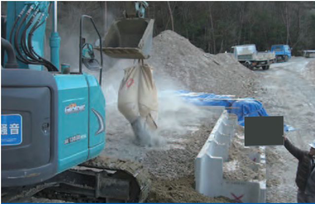
セメント改良(発生土仮置き場)
