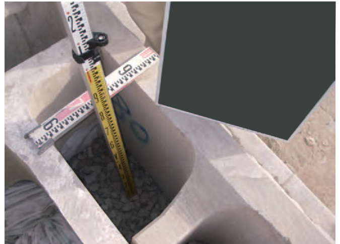
端部コンクリート投入前
