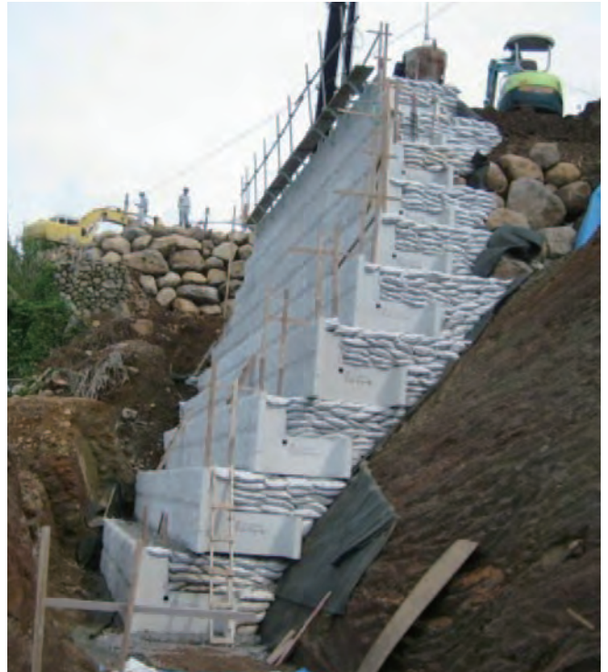
一次施工完了
