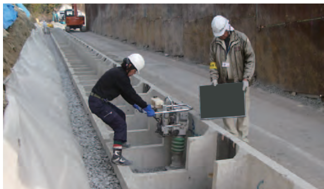
壁体材 1層目転圧
