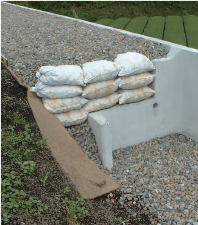
一次施工完了
