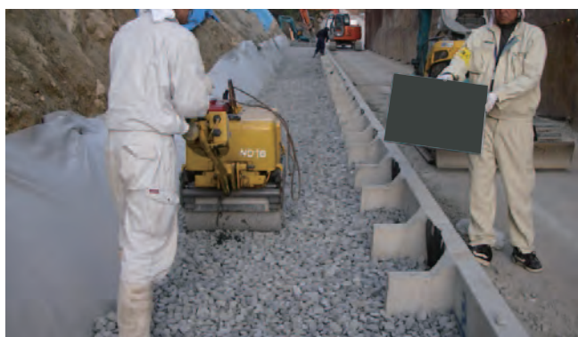
壁体材 3層目転圧
