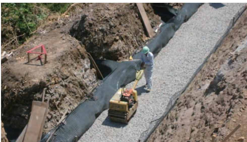
テンサー基礎工(転圧)
