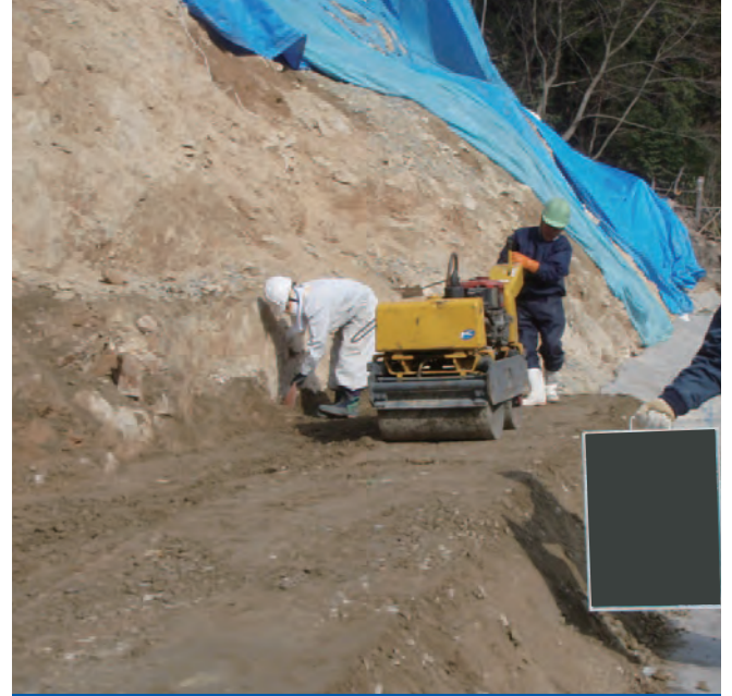
背面改良土転圧敷均し
