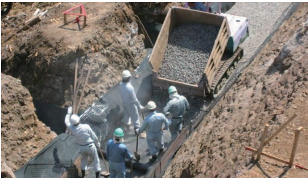
テンサー基礎工(単粒度碎石投入)
