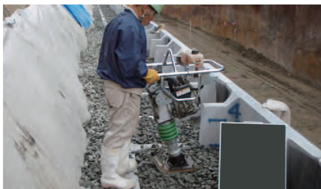
壁体材 2層目転圧
