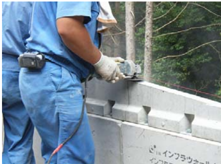
0000400046小山田2期地区試験施工053. JPG
