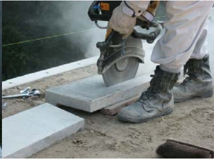
0000200010霧島市試験施工015. JPG
