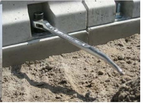
0000300037霧島市試験施工042. JPG
