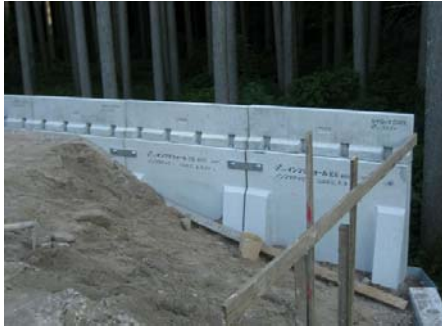
0000100006霧島市試験施工011. JPG
