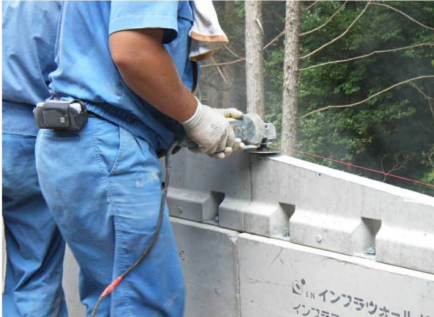
小山田2期地区試験施工053
