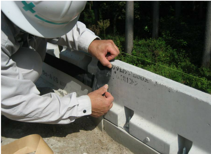
霧島市試験施工054
