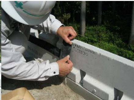
0000500049霧島市試験施工054. JPG
