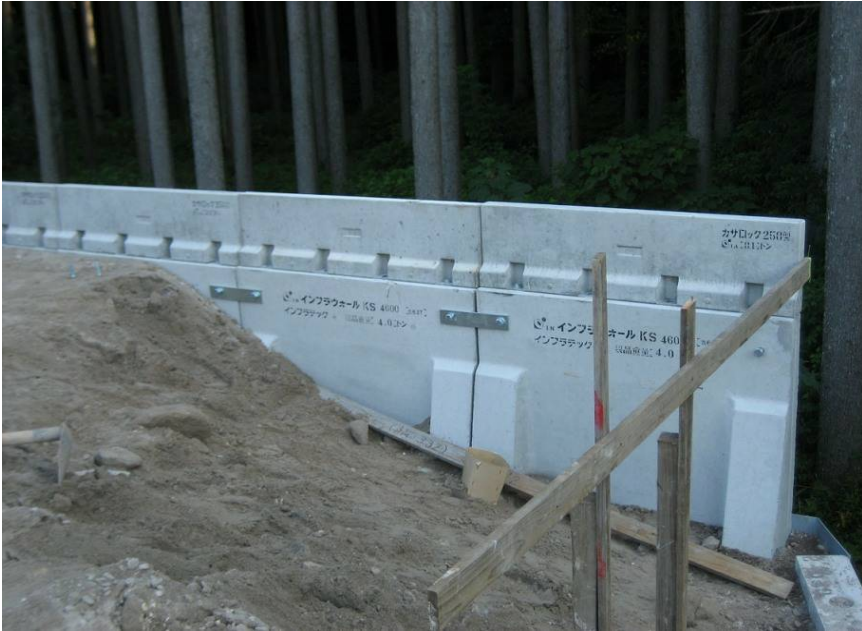
霧島市試験施工011
