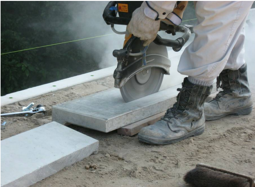
霧島市試験施工015
